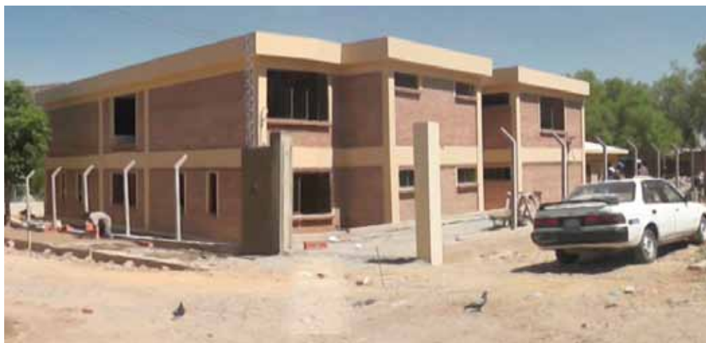
Construcción del Albergue Mosoj Ph'unchay en la ciudad de Cochabamba.
